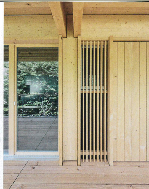
Mehr als ein Drittel des verbauten Holzes ist unverleimtes Massivholz aus der Region.
