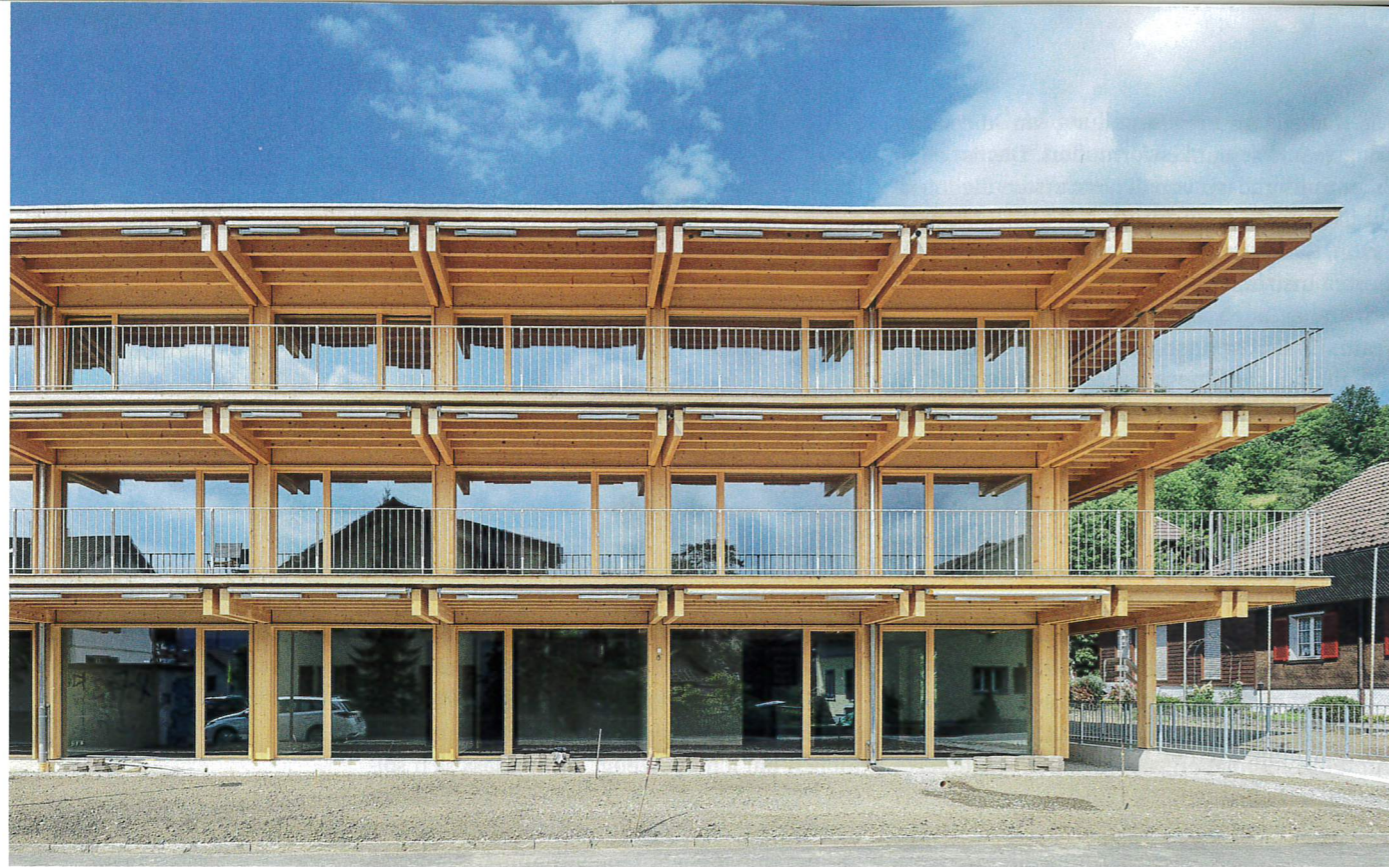
Das Generationenhaus Langnau ist ein dreigeschossiger, schlichter Holzbau mit Flachdach. Er wurde in ökologischer Bauweise im Minergie P-Standard erstellt. Das Wohnbauprojekt ist über viele Jahre in einem partizipativen Planungsprozess gereift.
