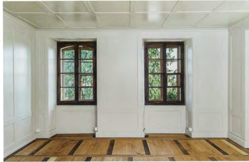
Abb. 18 Stube im Erdgeschoss, Blick gegen Süden mit den restaurierten einfachverglasten Fenstern aus Eiche mit Vorfenstern. Foto 2016.
